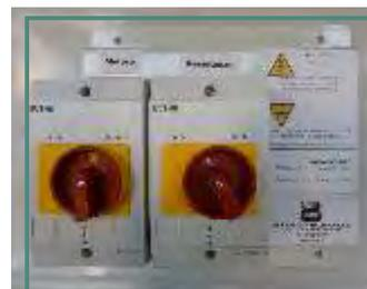
AS-E: deux interrupteurs magnéto-thermiques. L'un pour le moteur à vibration et l'autre pour le groupe chauffant. Pour faire démarrer le group chauffant il faut mettre le moteur à vibration en marche ; il ne peut pas fonctionner si l'interrupteur magnéto-thermique du moteur n'est pas en marche.
