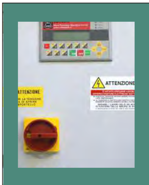
Vista frontale del quadro comandi serie MP/MPE, nella versione 230V - 50Hz oppure 400V -50 Hz a secondo del modello della macchina.
